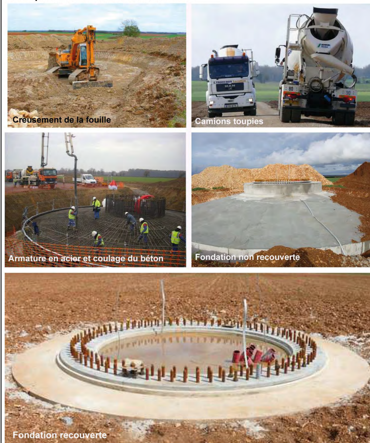
Photographie 27 : Etapes de réalisation d'une fondation d'éolienne
