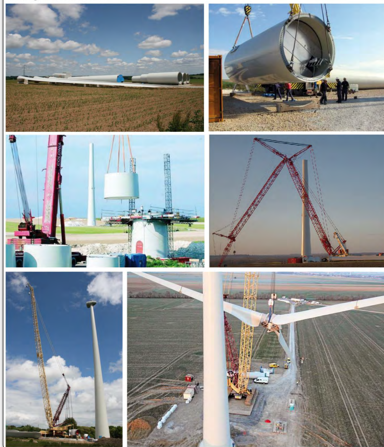
Montage d'une éolienne
