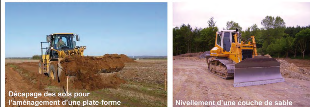
Photographie 26 : Exemples d'engins de travaux de VRD
