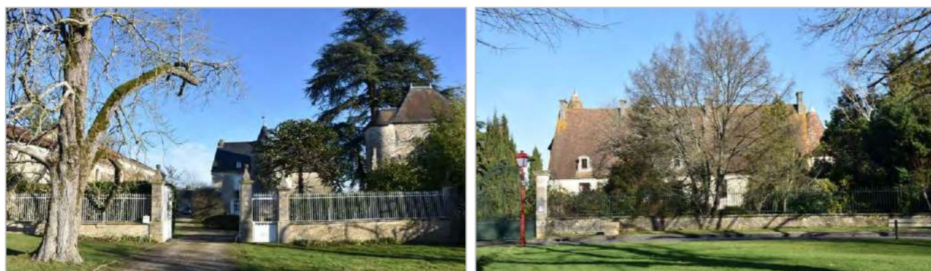
Photographie 11 : Château de Mauprévoir (à gauche) et de Jossé (à droite) (Source : ENCIS Environnement)
